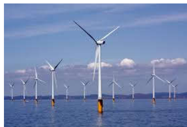
3000V AC /5MW 海上风电
